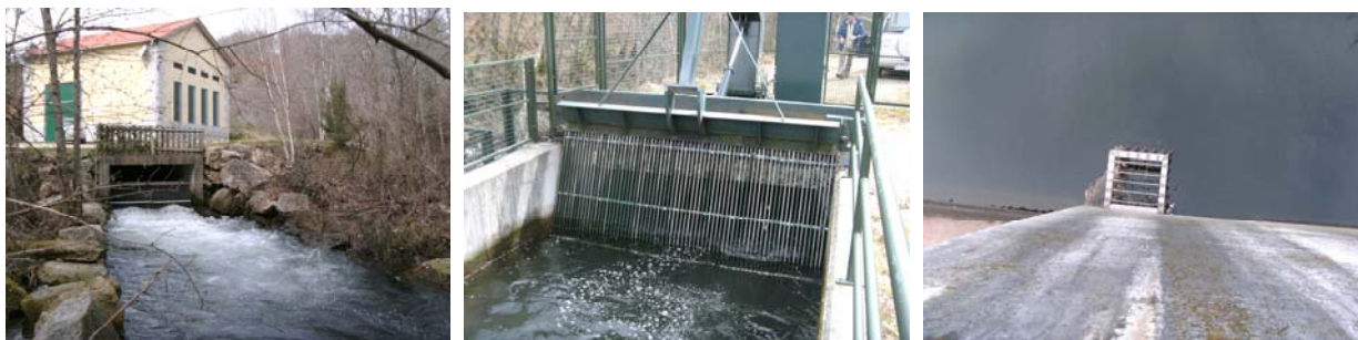
Rejas de protección en los canales de toma y restitución y altavoz de la barrera sónica de peces en el AH Cadós (Ourense).
