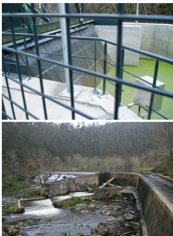
By pass en el AH A Merca en Ourense (foto superior) y AH Allóns en A Coruña y esquema de un by pass de peces tipo con rejas tipo tambor
