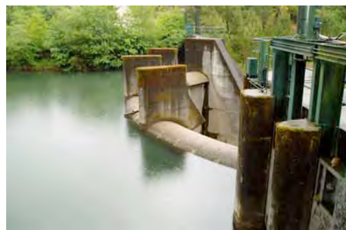
ALNUS-BSP en la obra de toma del AH Cabo (Pontevedra)
