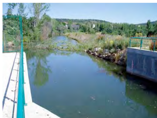
ALNUS-BSP en el AH de Puenteadura (Burgos)
